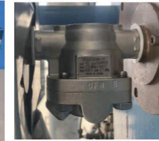
蒸気輸送配管用フリーフロー・スチームトラップ
