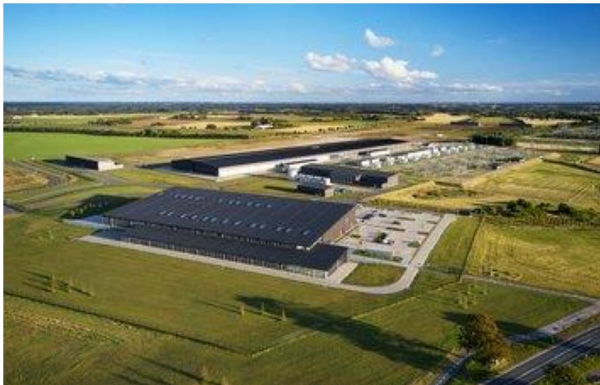
Viborg Green データセンター
