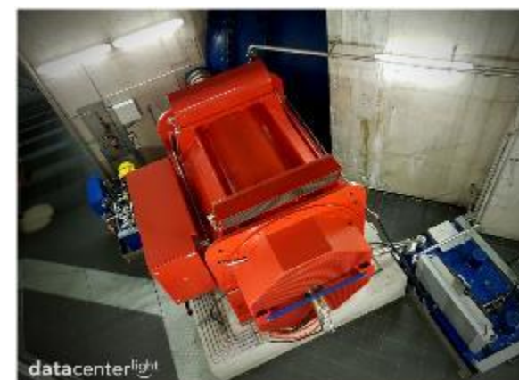
Data Center Light内の水力発電ユニット
