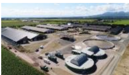
バイオガスプラント(北海道土幌町)
