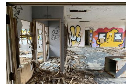
撤去前の廃屋（内観）
