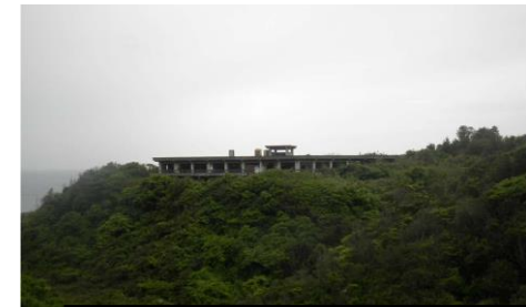
撤去前の廃屋（遠景）
