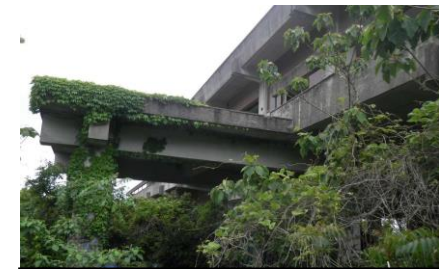
撤去前の廃屋（外観）
