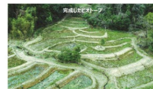
完成したビオトープ
