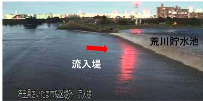
令和元年東日本台風 洪水時の状況(流入堤付近)
