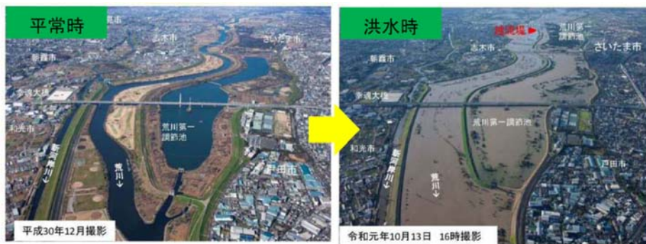
令和元年東日本台風 洪水時の状況(調節池下流から)
