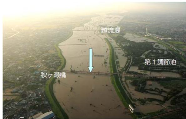
図 2.4 荒川貯水池（彩湖）の洪水調節状況（平成19年9月）
