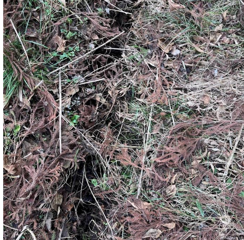
放棄された水路
