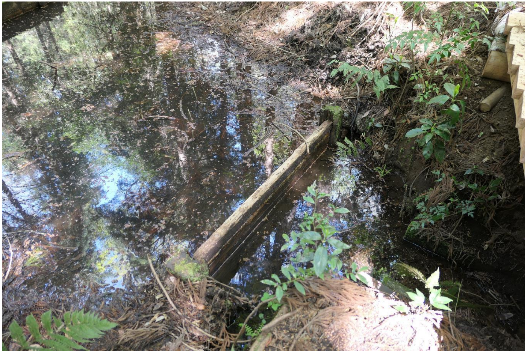
西水路（幅約1m 全長80m） 堰（木製）を設置 6カ所
