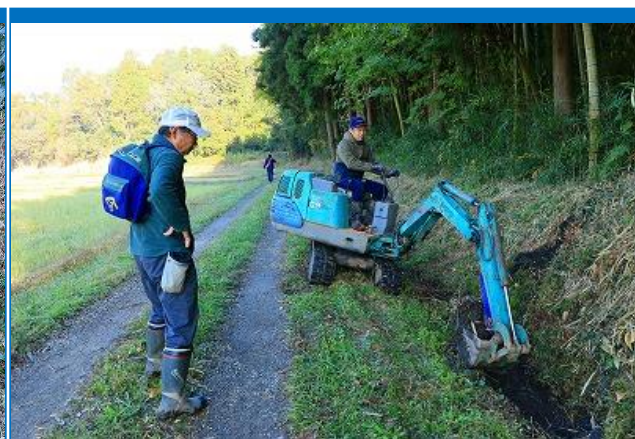
重機による掘削
