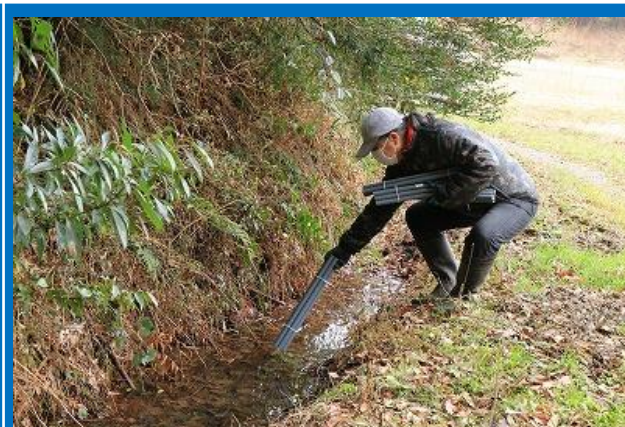
塩ビ管の設置
