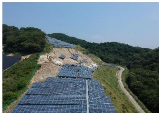
傾斜地の崩壊が発生したため、法肩部分の架台が流出した事例
