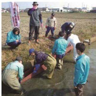
④集落総出で魚道を設置
