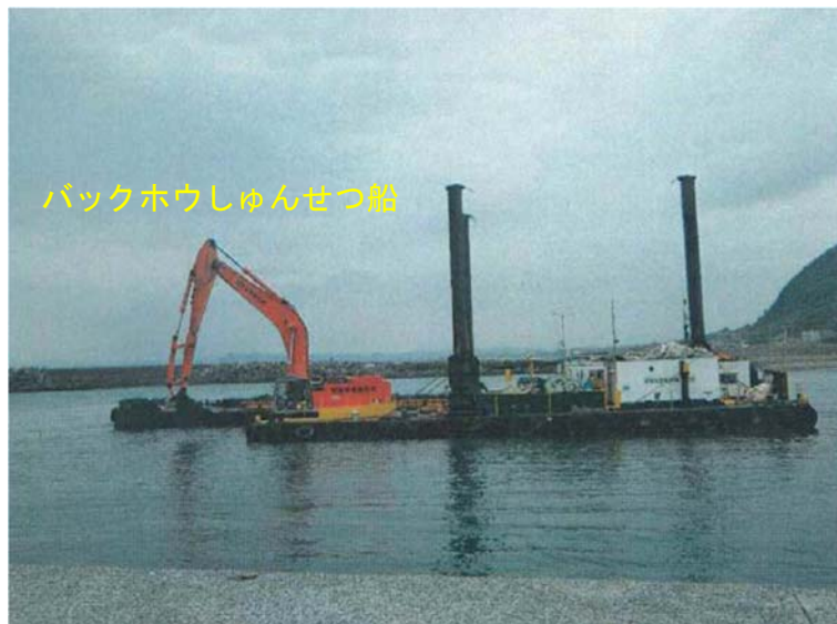
図1 しゅんせつ作業状況 (例)
