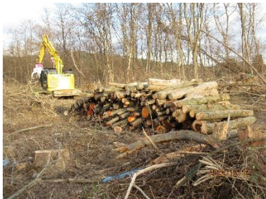
伐採状況（白川左岸）
