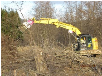
伐採状況（白川左岸）
