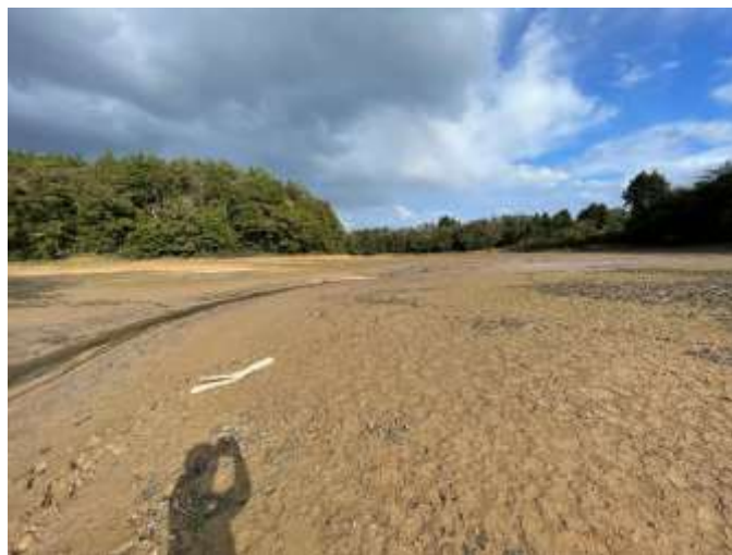
維持管理の一環として水抜きされたため池
