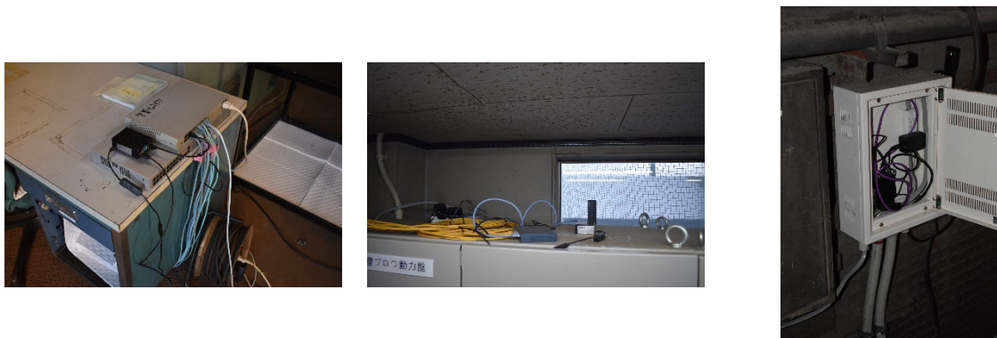
図表 89 イーサネットハブ・ボード PC 設置状況（左：A 社、中央・右：B 社）
