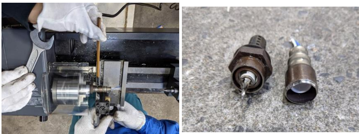
図 55 O2 センサーの切断状況（左）と切断後の状況（右）
