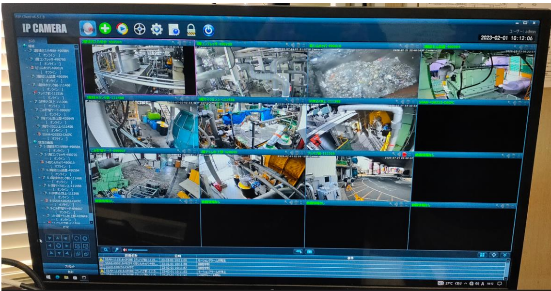
図 5-4-5 中央制御室での監視状況
