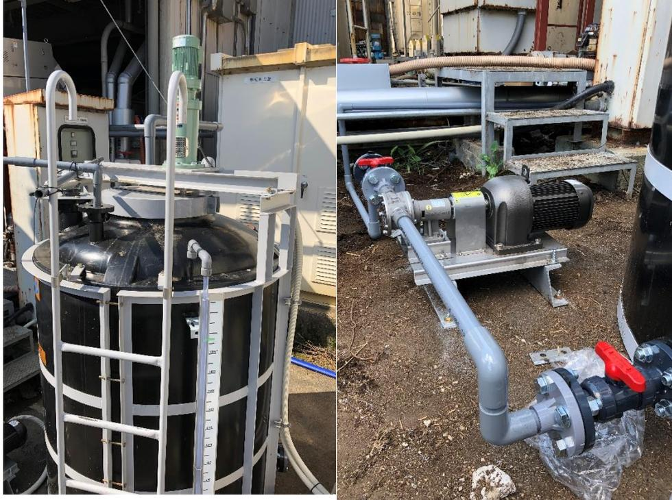
図6 TK-302\_分離液槽、PU-302\_分離液ポンプ
