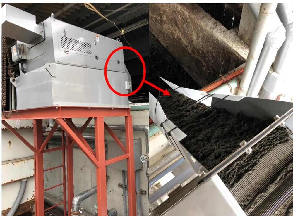
図5 EM-301\_固液分離機、汚泥排出シュート部
