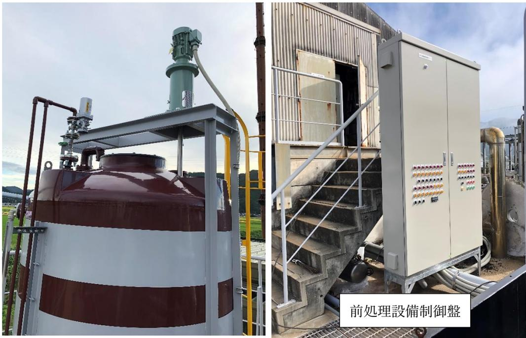
図9 TK-307\_濃縮液槽, 前処理設備制御盤
