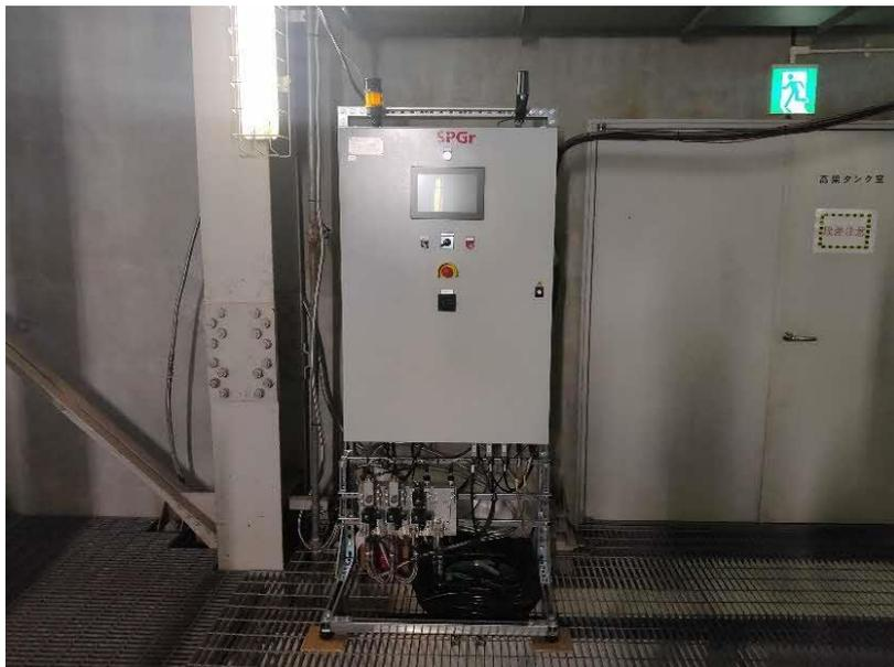
図 3-14 圧力波式スートブロワ設置状況（制御盤）
