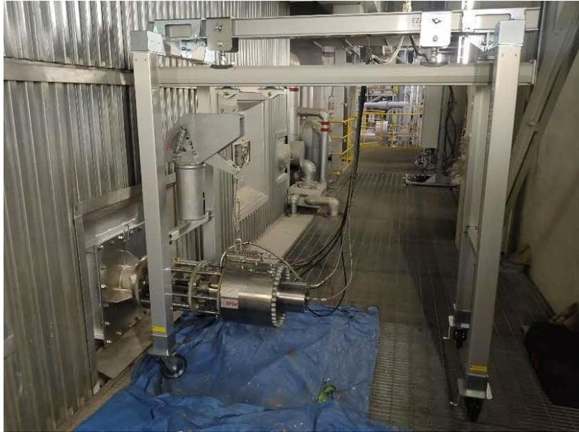
図 3-13 圧力波式スートブロワ設置状況（スートブロワ本体）
