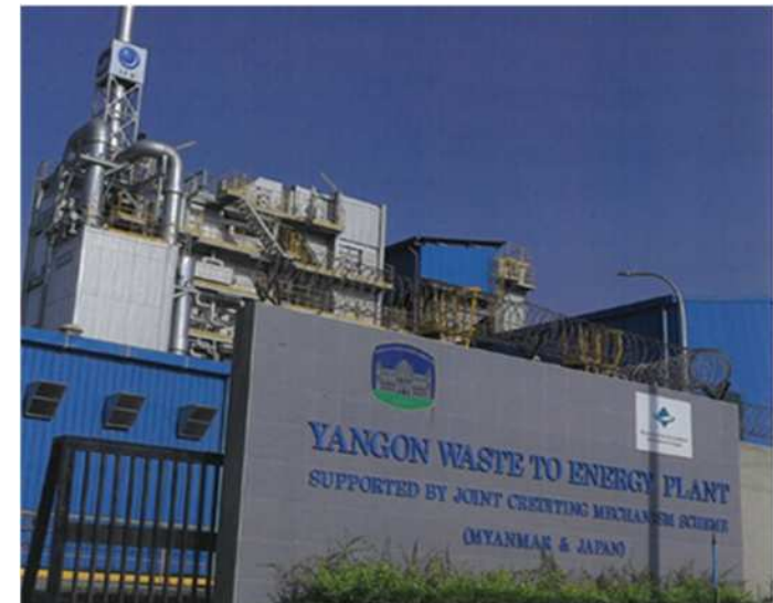
国際展開によりヤンゴンで稼働中の廃棄物処理施設 出典：環境省
