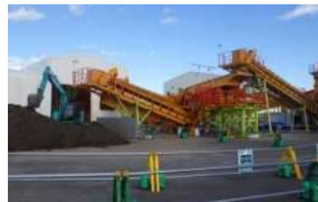
檜葉町の仮置場内破碎選別設備 出典：環境省
