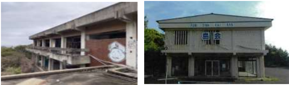
R3、R4に撤去した廃屋
