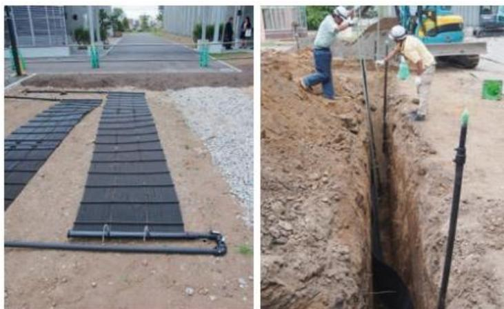
図 3-21 シート状の熱交換器<sup>75</sup>
