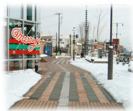
道路融雪(青森県弘前市)
