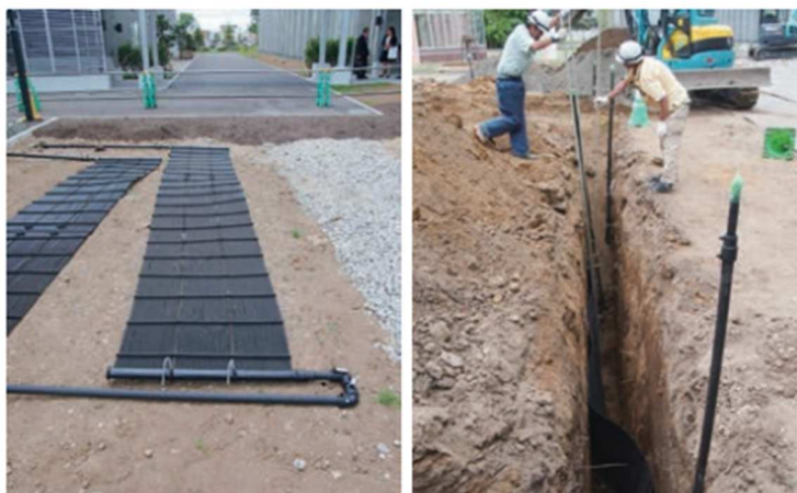
図 3-21 シート状の熱交換器 74
