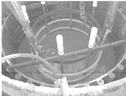
杭基礎内らせん配管敷設
