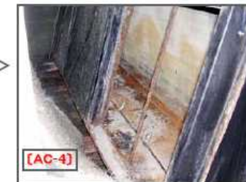
空調機AC-4の内部
