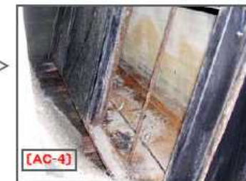
空調機AC-4の内部
