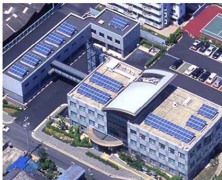
国土交通省中部地方設備局北勢国道 工事事務所（陸屋根型）三菱電機
