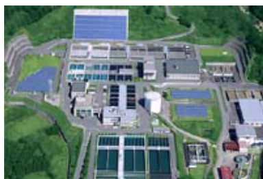
御所浄水場 シャープ
