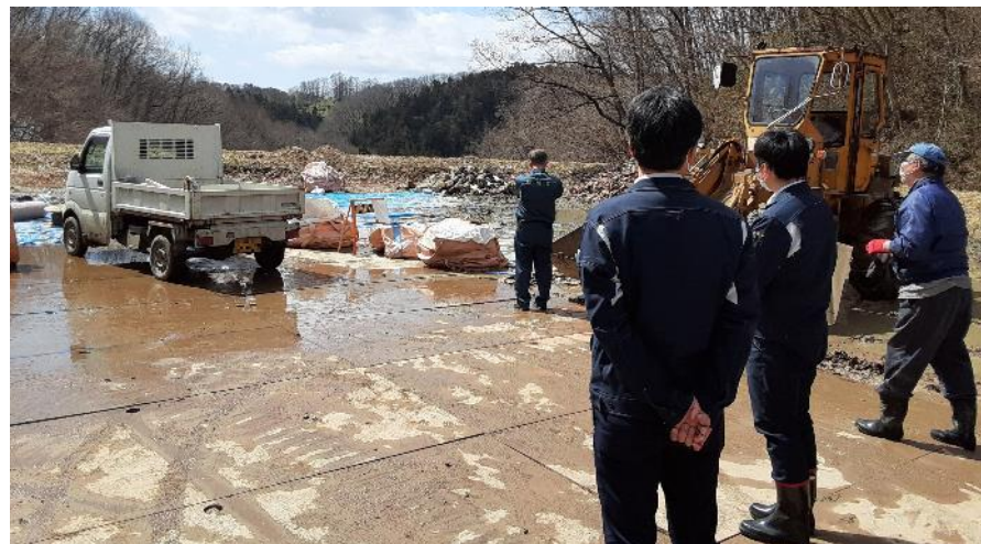
田村市 仮置場での鉄板敷設確認立会い 環境省撮影 (令和4年3月24日時点)
