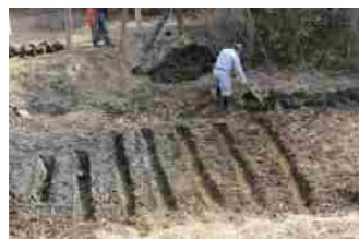
土砂堆積部分の浚渫
