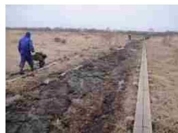
水抜き水路の埋め戻し
