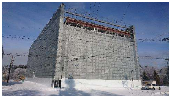
廃屋ホテルの解体風景
