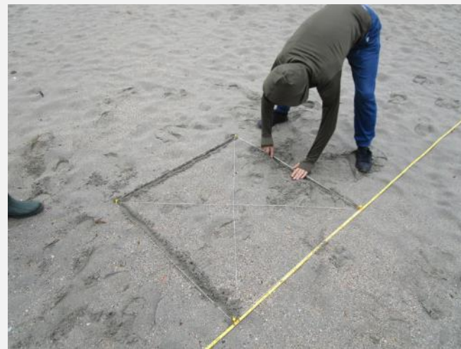
杭打ち・試料採取面の確定
