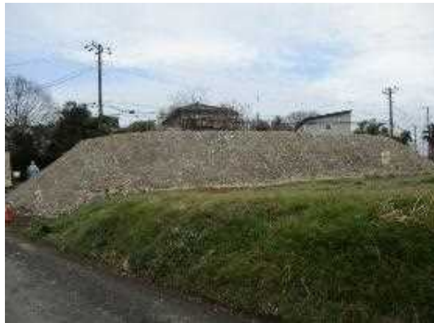
支障除去実施中 (種子吹付前)
