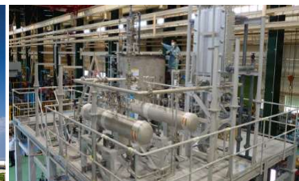
マレーシアに輸出される世界初の H-OTEC プラント
