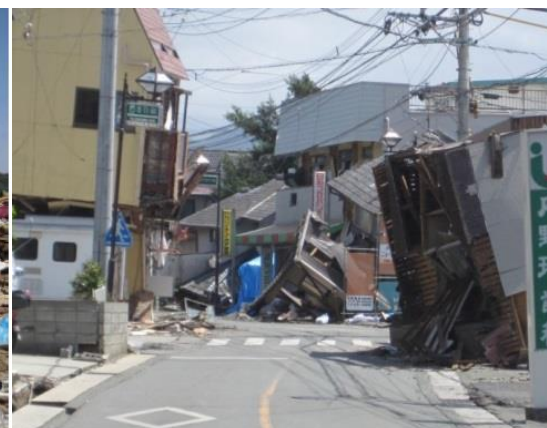
損壊建物（地震）
