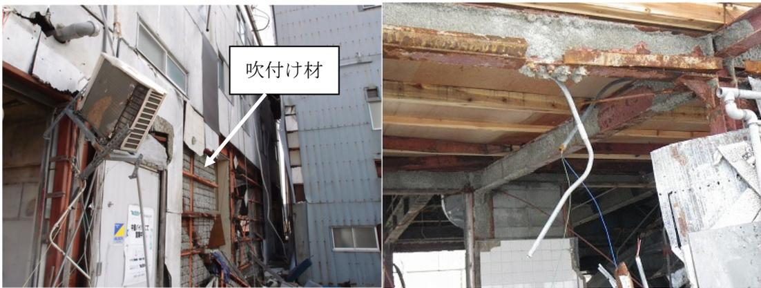
吹付け材が露出している例
