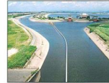
谷田川分離施設
