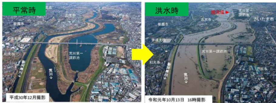
令和元年東日本台風 洪水時の状況(調節池下流から)
