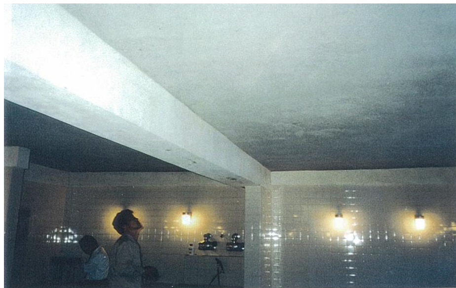
温泉の浴室天井に 吹き付けた例 (断熱・結露防止)
