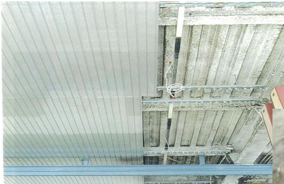
屋根用折板断熱材の施工例
