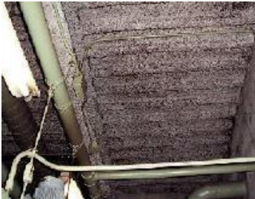
折板屋根の裏面に 吹き付けた例(断熱)
