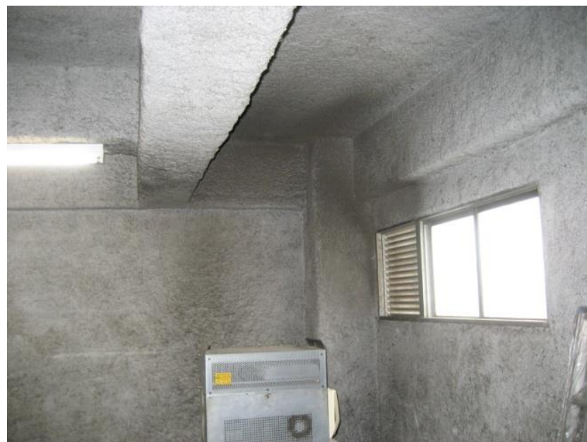
機械室の壁・天井に吹付けた例 (吸音) …壁と天井の材質に注意
