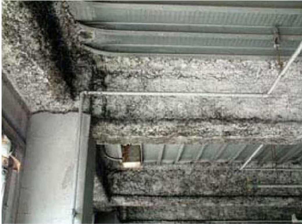
鉄骨造の梁に吹付けた例 (耐火被覆)
