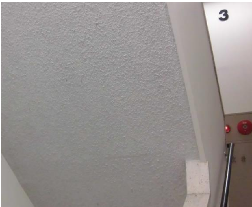
階段の天井に吹付けた例(吸音) …この例は塗装を実施
