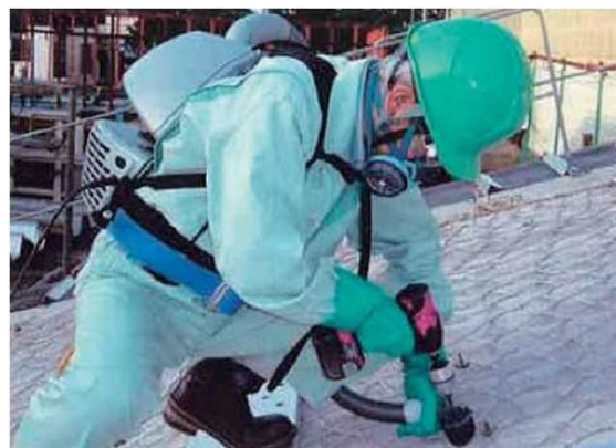
集じん回収（高性能真空掃除機）
