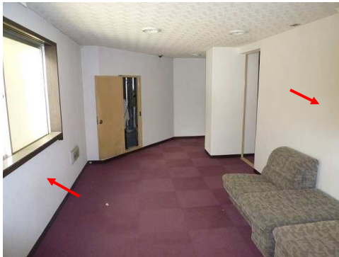
せっこうボード下地クロス仕上 ※不燃クロスも石綿懸念あり
