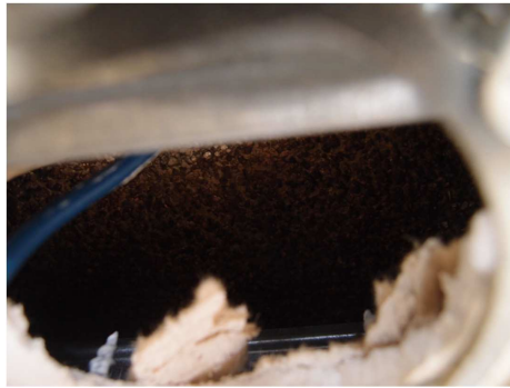
最上階の天井材を破壊し、 屋根裏に施工された吹付けパーミキュライトを確認
