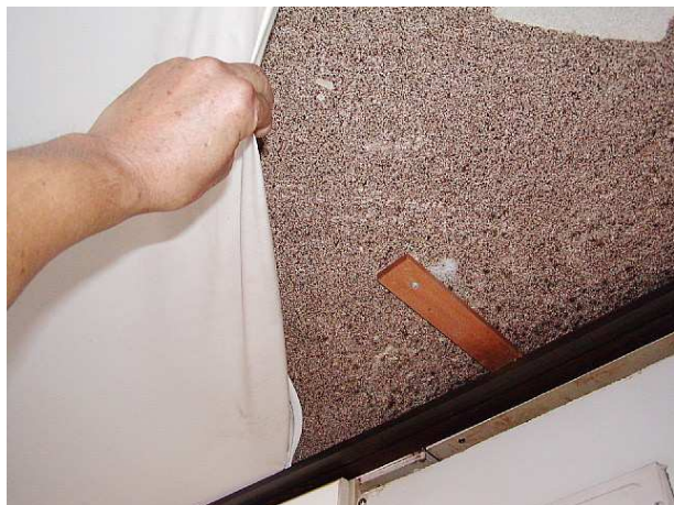
共同住宅の居間天井（パーミキュライト） ビニール被膜による囲い込み工法
