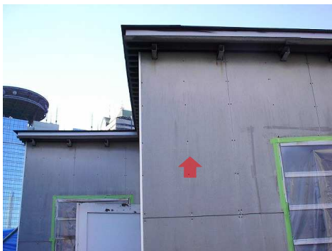
石綿スレート平板
