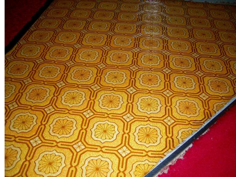
クッションフロアは石綿を含有したものがある
