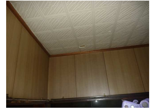
天井 ロックウール吸音板
