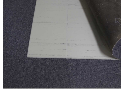
タイルカーペットの下に、ビニル床タイルが残っている場合がある。
