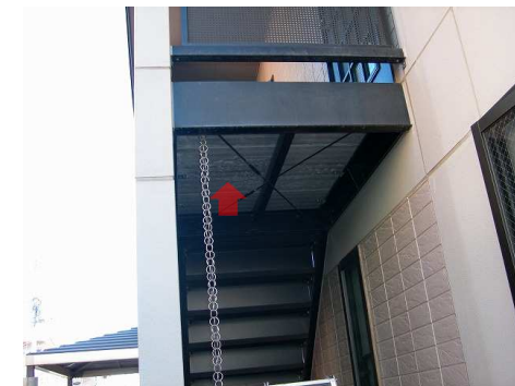
外階段の踊り場に使用された押出成型セメント板
