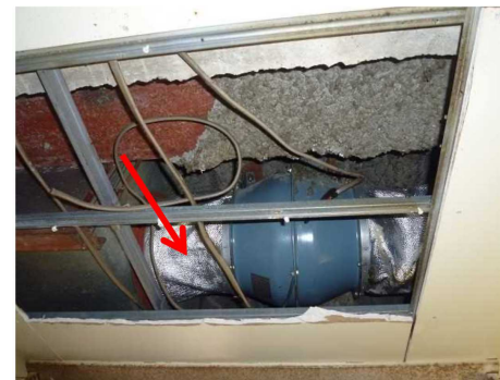
天井板を取り外すと、 鉄骨梁の吹付け耐火被覆と ダクトのたわみ継ぎ手を確認
