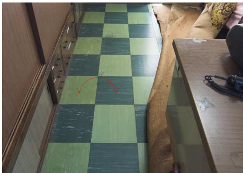
2種類のビニル床タイルで施工 (2試料)
