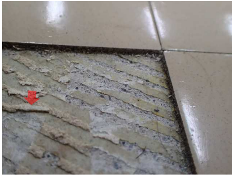
クリンタイル含有の接着材
