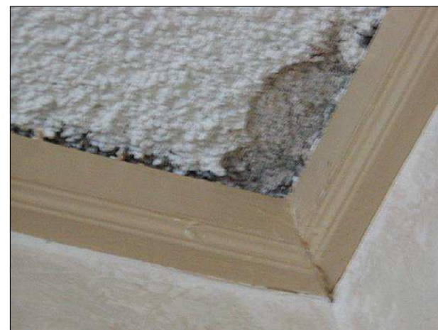
居室 吹付け石綿の上から石綿対策工事として吹付けパーライト
