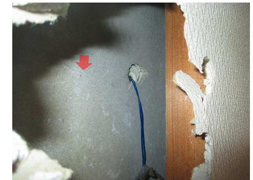
ユニットバス裏側壁
