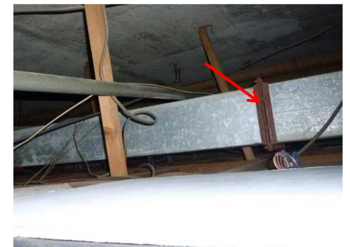
天井点検口の目視調査でダクトのパッキンが確認
