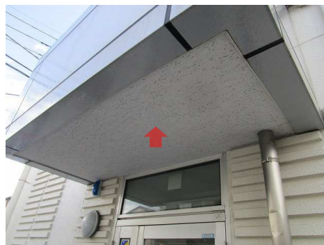
庇裏 岩綿吸音板 (外部の場合は、捨貼りが けい酸カルシウム板第1種 )
