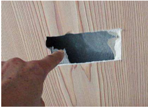
最上階の天井材を破壊し、 屋根裏に施工された吹付けロックウールを確認
