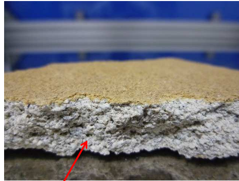
砂壁状の部分から白石綿（クリソタイル）が検出
