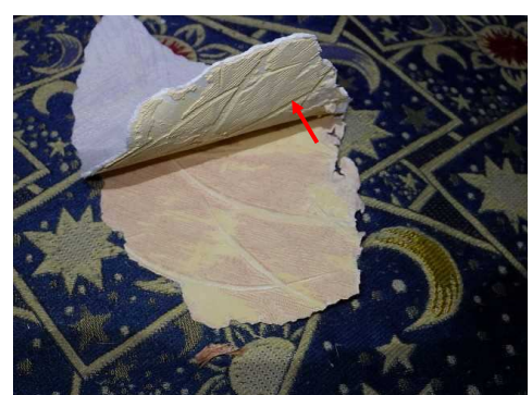
改修された壁: 旧仕上げの上に改修のクロス仕上げ (パテ材から石綿検出)
