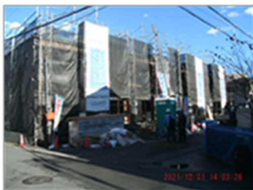
写真 4.3.7 工事現場全景
