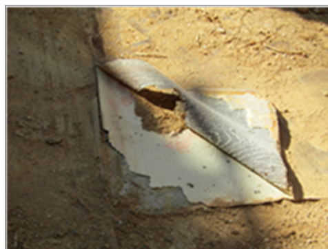
写真 4.3.28 ビニル床シート接着状況
