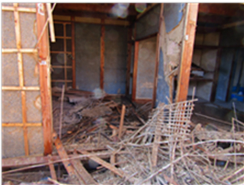
写真 4.3.35 土壁の状況（壁土撤去後）
