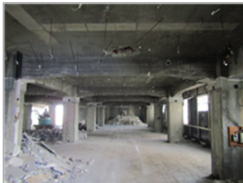
写真 4.3.12 施工状況（内装材除去）
