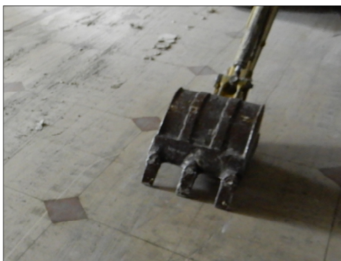
写真 4. 3. 13 ビニル床タイル(除去状況)
