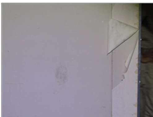
写真 4. 3. 15 内壁の壁紙(除去前)
