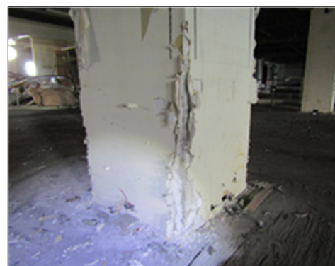
写真 4. 3. 16 柱の壁紙(除去中)
