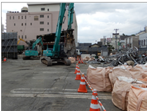
写真 4.3.11 工事現場全景
