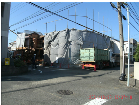
写真 4.3.25 工事現場全景
