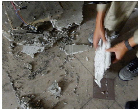
写真 4. 3. 14 ビニル床タイル(除去後)
