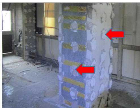
写真 4.3.19 接着剤（廃石膏ボード除去後）
