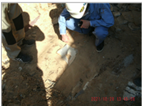
写真 4.3.27 土間のビニル床シート
