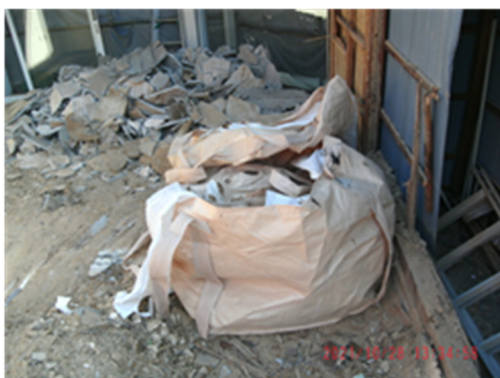
写真 4. 3. 31 廃プラスチックの分別状況
