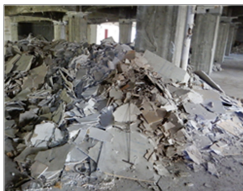
写真 4.3.20 廃石膏ボード（除去後）
