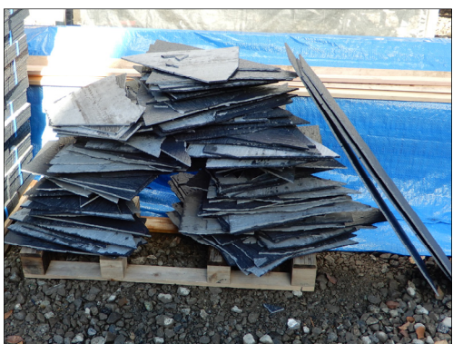
写真 4.3.9 屋根下防水材の分別状況
