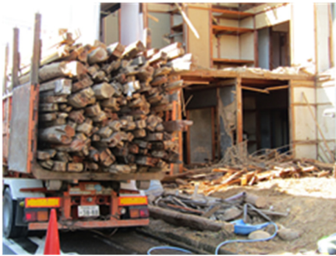
写真 4.3.33 木材（柱材等）の搬出状況
