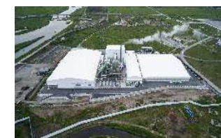
浪江町 仮設焼却施設
