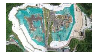
特定廃棄物埋立処分場
