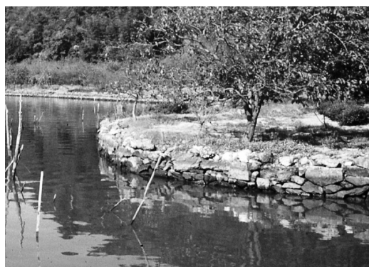
石積み護岸（昭和 50 年頃）
