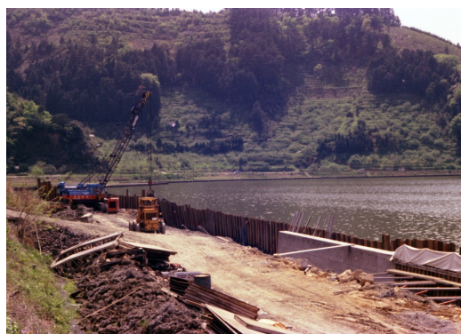
コンクリート護岸工事（昭和 50 年頃）
