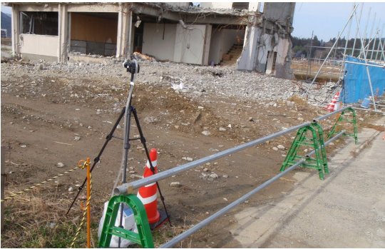
損壊建築物近傍での測定例
