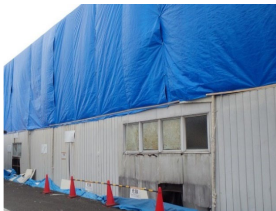
図3.6 応急飛散防止措置の例
