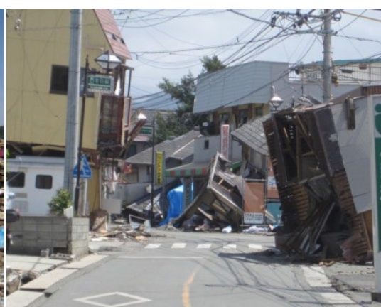
損壊建物（地震）
