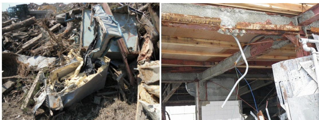
津波により流された断熱材
