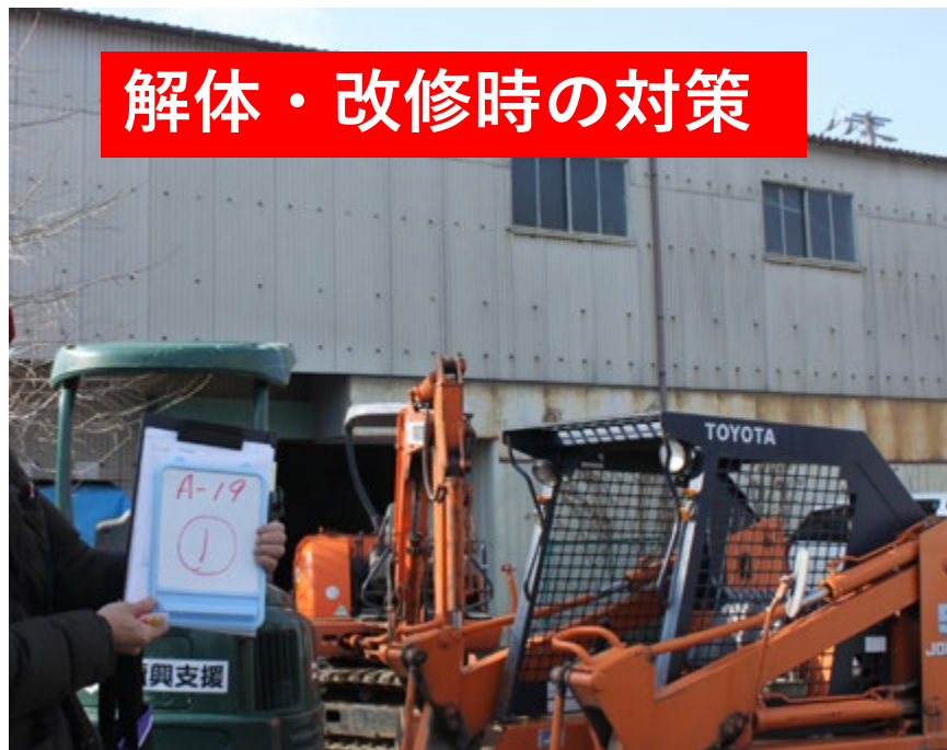
写真 波板スレートの倉庫
