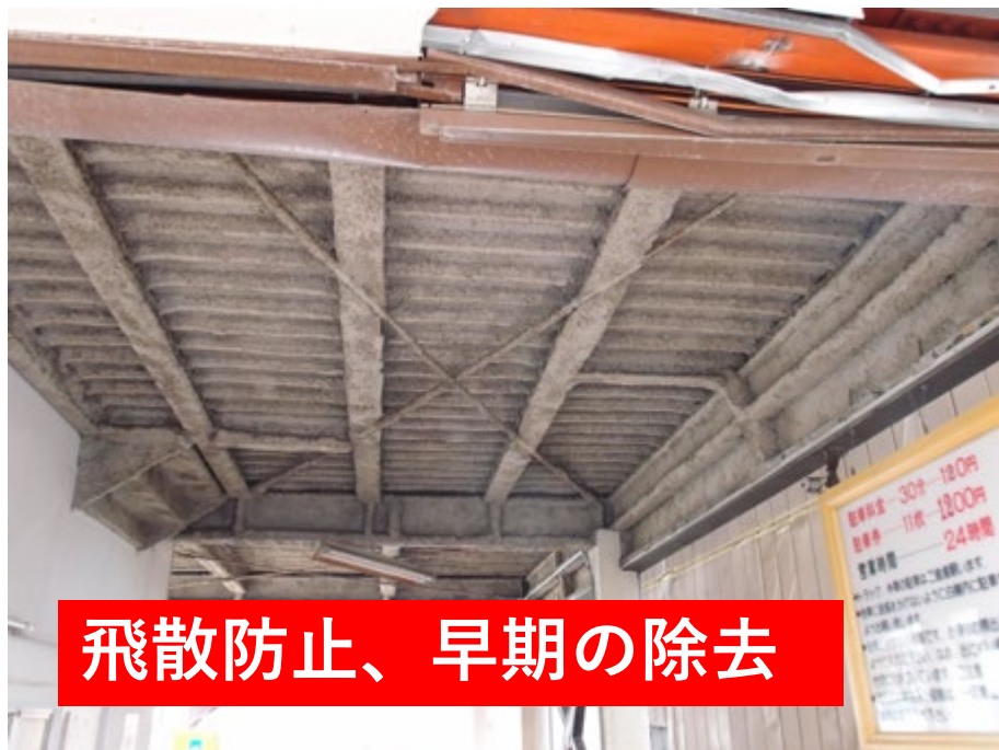
写真 吹付け耐火被覆（吹付けロックウール）
