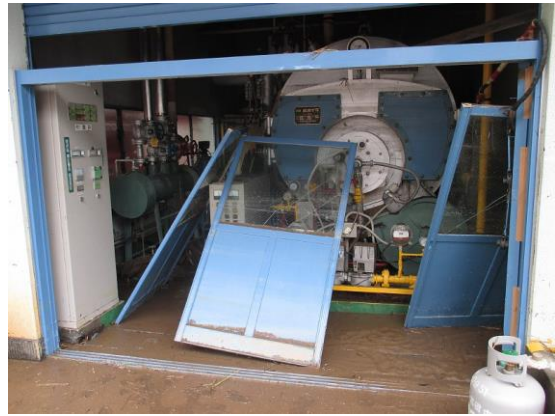
(左・右：し尿処理施設の被災状況（写真左のドラム缶は場外からの流入物。これらも扉を破壊した要因のひとつとして考えられる。))
