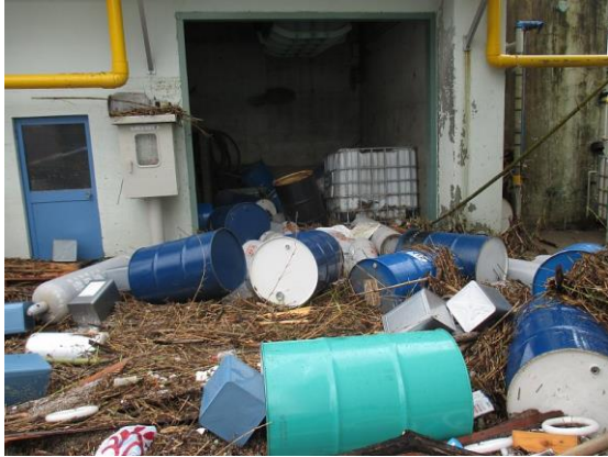
(左・右：し尿処理施設の被災状況（写真左のドラム缶は場外からの流入物。これらも扉を破壊した要因のひとつとして考えられる。))
