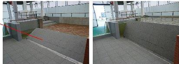
図2 フラップゲート自立時写真
