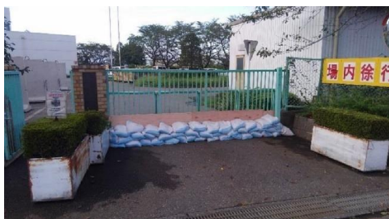
水の流入口となる施設出入口への土嚢の設置
