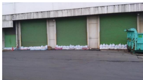
施設シャッター部への土嚢の設置
