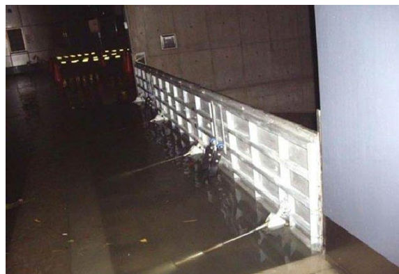
起伏式止水板で地下駐車場への浸水を防止した事例
