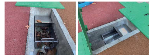
MPフィルター設置時の様子
