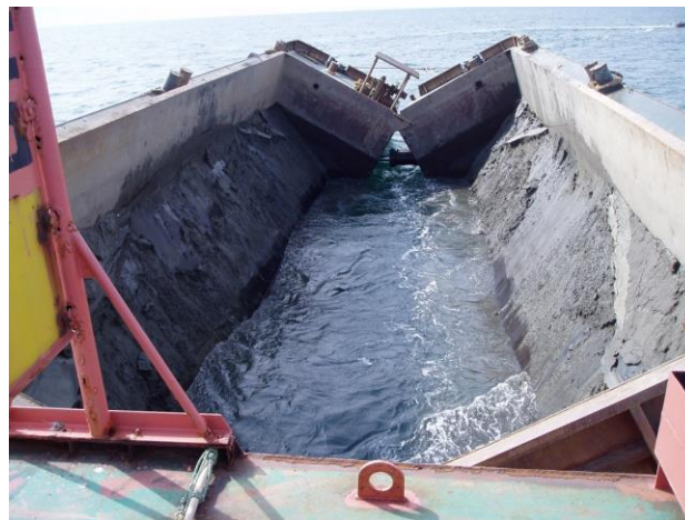
写真-3.3 土運船によるしゅんせつ土砂排出状況
