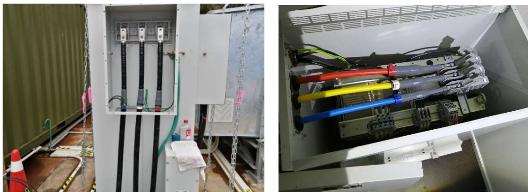
図 3.4-6 エクスポートケーブル陸上設備接続状況
