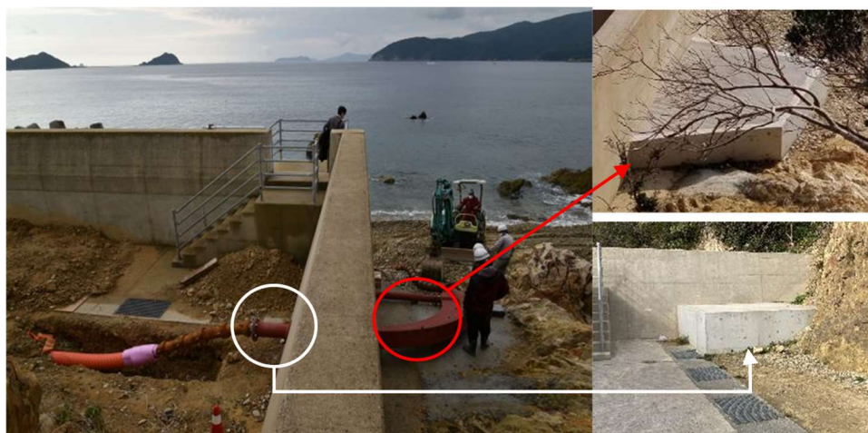
図 3.6-4 防波堤貫通部状況
