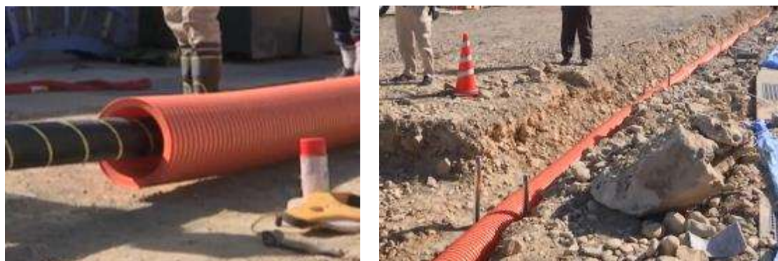
図 3. 6-5 エフレックス管（左）及び埋設工事の状況（右）
