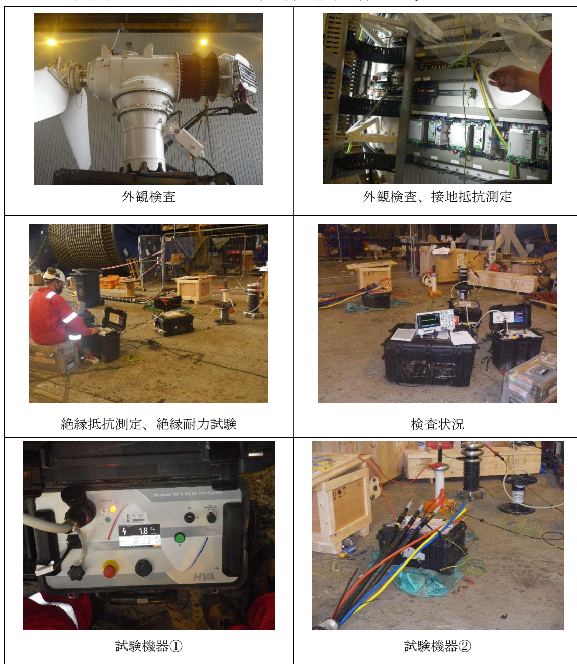
図 4.2-5 英国での使用前検査状況
