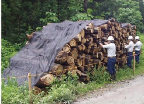
寒冷紗を用いて、表面の乾燥を防ぐ
