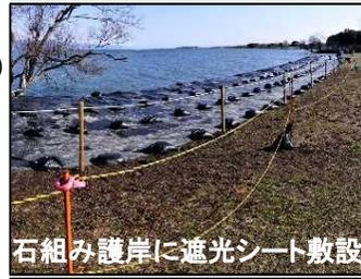
石組み護岸に遮光シート敷設
